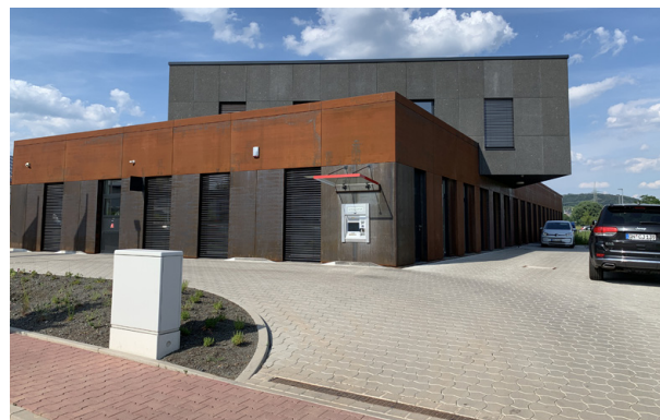
Textilbetonfassade der Sparkasse Gründau mit betoShellSiut®
